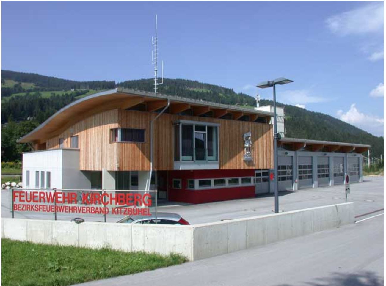
Das vierte Zeughaus der Feuerwehr Kirchberg, 2001
