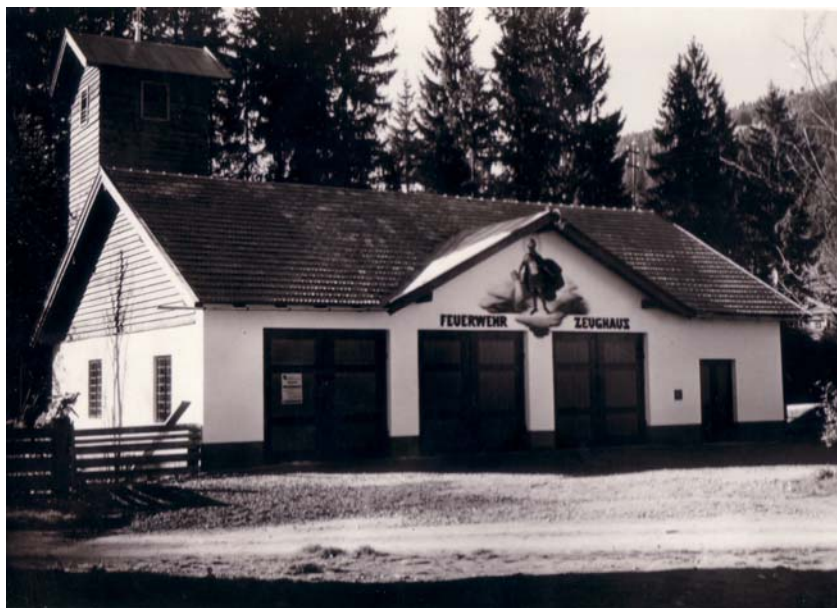
Zweites Zeughaus der Feuerwehr Kirchberg (1936-1972)
